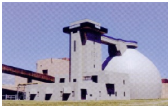
卵形消化タンク(原田処理場)
