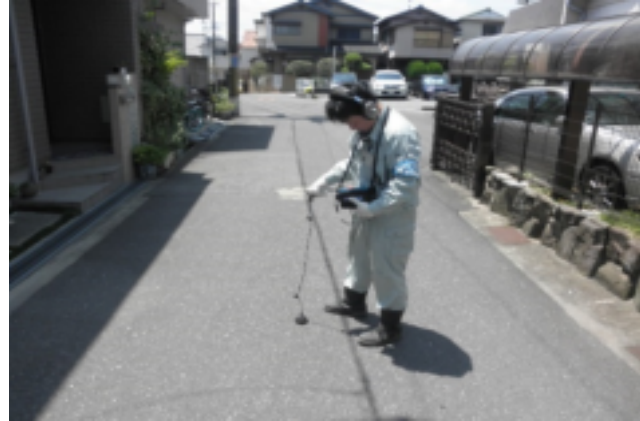
漏水探知機で漏水音を調査している様子
