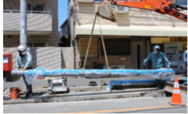
水道管を入れ替えている様子
