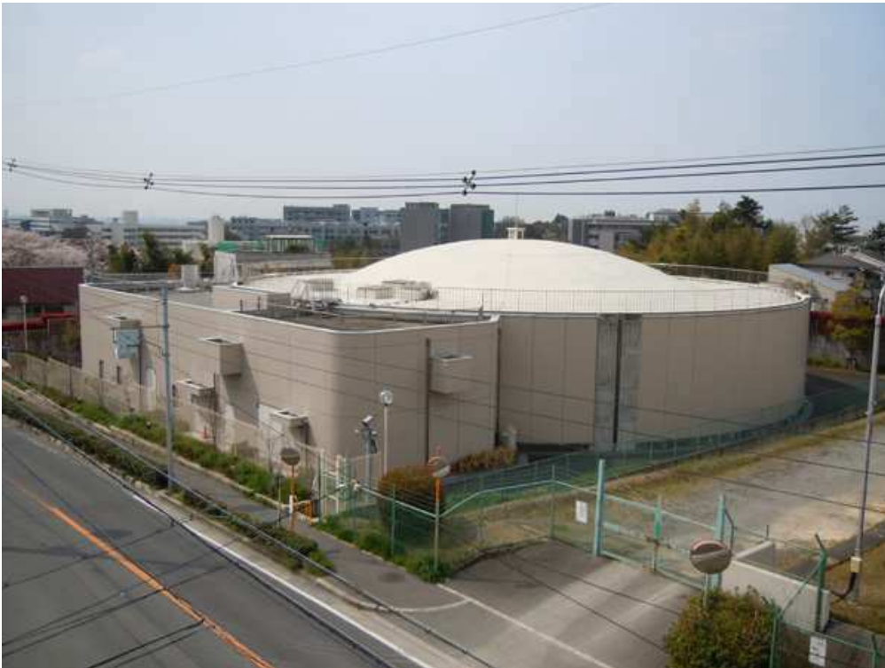
柴原配水場全景
