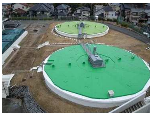
柴原浄水場沈殿池
