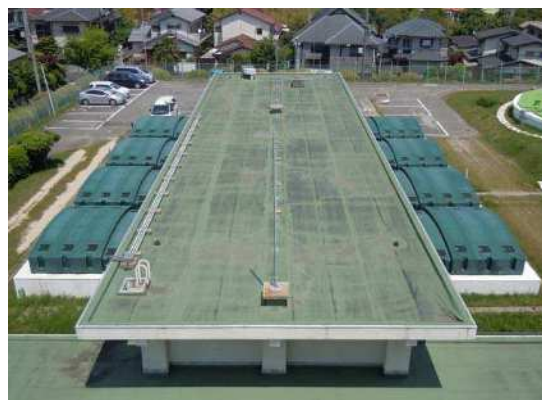
柴原浄水場ろ過池
