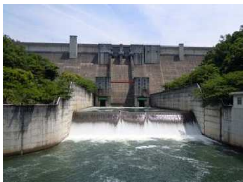
一庫ダム放流設備
