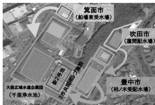
柿ノ木配水場
