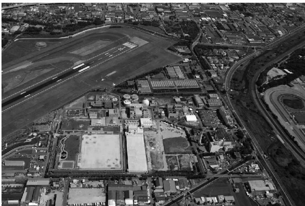
猪名川流域下水道 原田処理場
