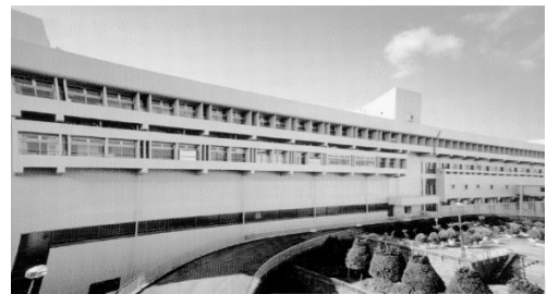
庄内下水処理場
