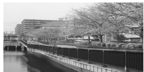
中央景観水路
