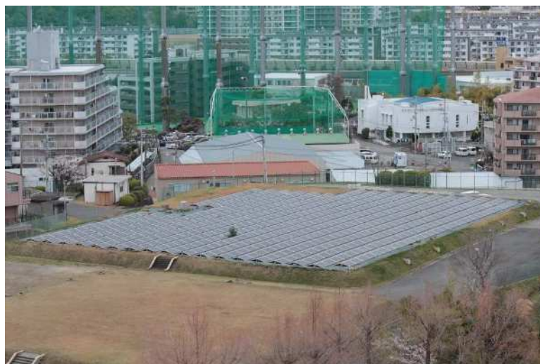
新田配水場全景
