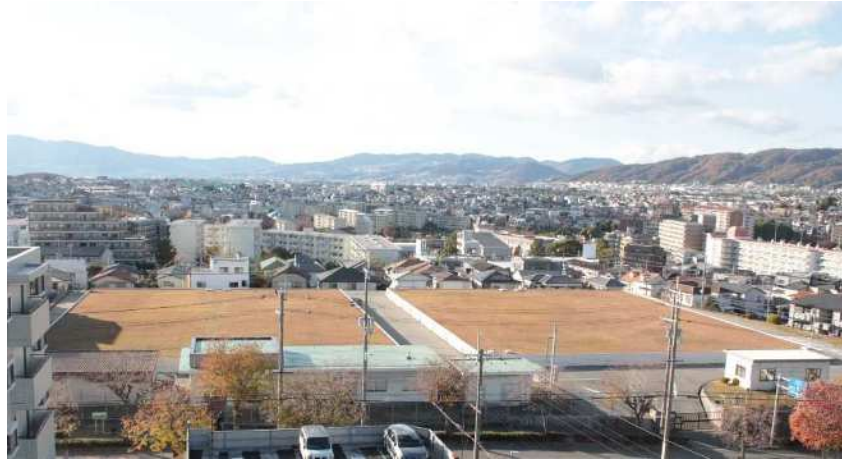
野畑配水場全景
