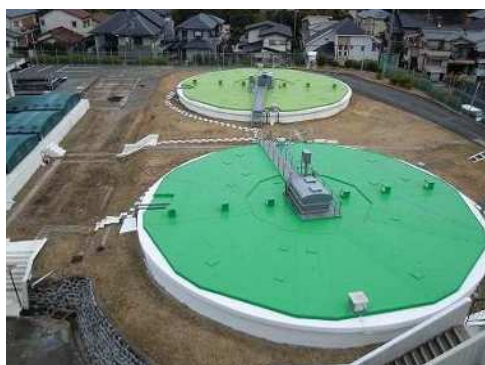
柴原浄水場沈殿池
