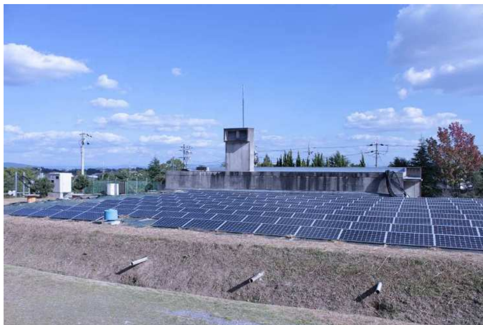
柿ノ木配水場
