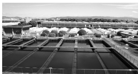
原田処理場 水処理施設
