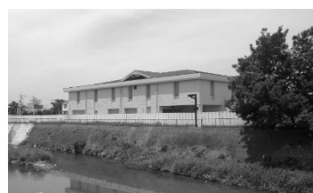
千里園ポンプ場(千里川側)
