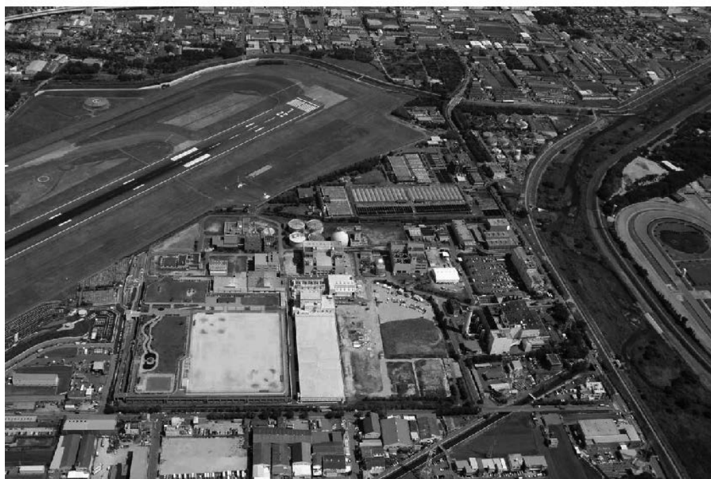
猪名川流域下水道 原田処理場
