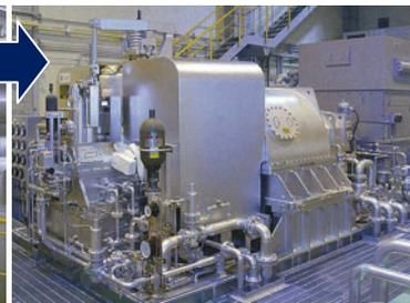
ボイラで得られた蒸気を利用して、蒸気タービン発電機で発電を行います。
