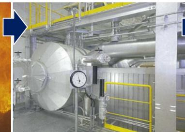
この熱をボイラ内部の水と熱交換して、高温高圧の蒸気をつくります。
