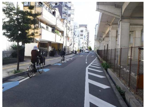
車道混在型の通行状況(阪急東側線)
