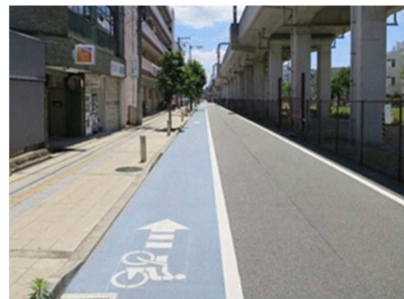
試験施工（阪急東側線）
