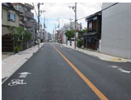
試験施工（東豊中線）
