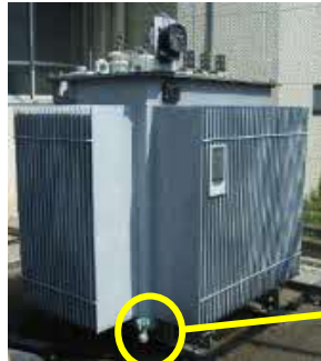
採取口付きの変圧器からの絶縁油の採取
