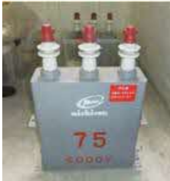
電力用コンデンサー
