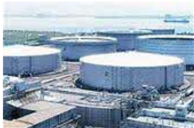
石油貯蔵タンク
