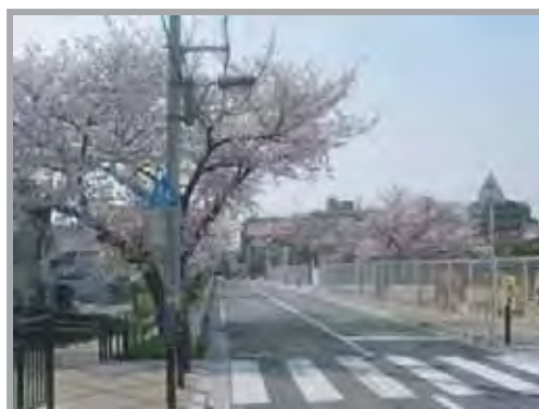
歩道も整備された生活道路
