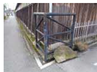
[写真 3-96] 外周北東部鉄製柵
