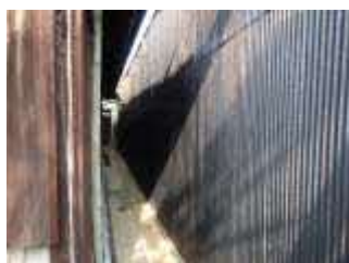
[写真 3-83] 波板鉄板
