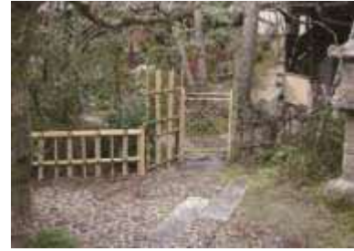
[写真 3-50] 枝折戸 (擬竹製)・金 閣寺垣 (擬竹製)・四つ目垣 (擬竹 製)・枝垣
