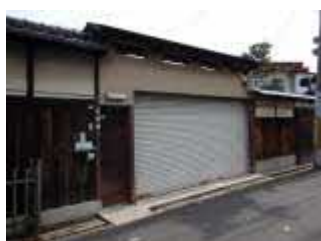
[写真 3-80] 通用門、シャッター
