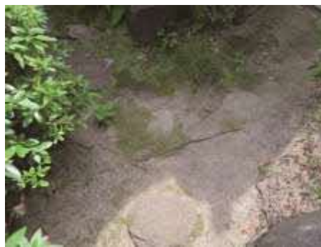
[写真 4-8]飛石周辺の土砂堆積（北西庭）
