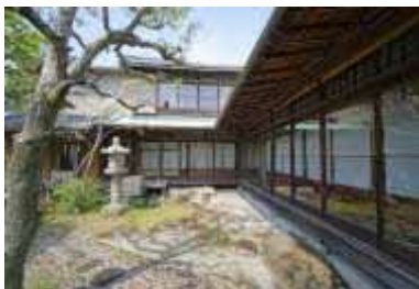
〔写真 3-62〕 主屋南北棟
