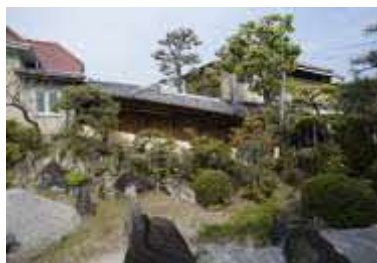
〔写真 3-63〕 渡廊下外観
