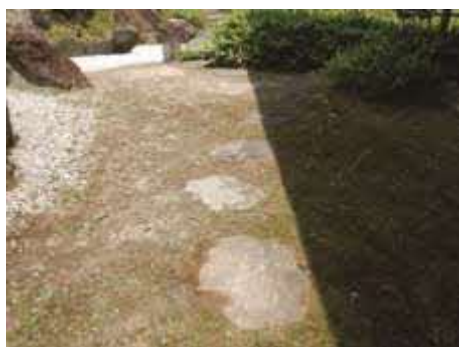
[写真 4-9]飛石周辺の土砂堆積〔南庭（青龍庭）〕
