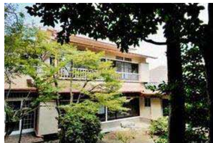
〔写真 2-1〕旧羽室家住宅主屋の外観
