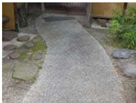
[写真 4-10] 飛石から舗装への改修〔南庭（青龍庭）〕
