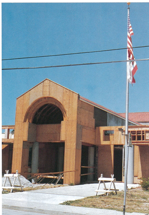
サンマテオ市庁舎（改築中）
