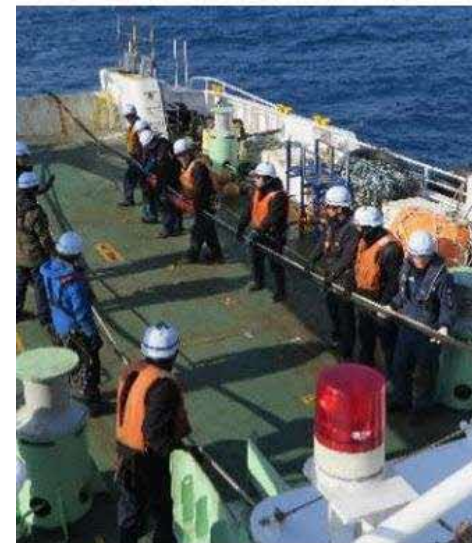
③海底ケーブルの再敷設作業
