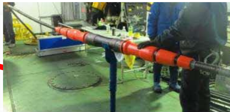
②海底ケーブルの接続作業
