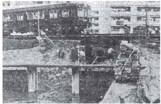
写真1-1 阪急電鉄下の水路拡張工事
