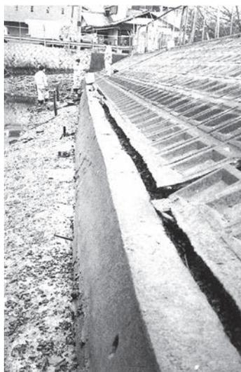
写真3-14 蛍池護岸亀裂
