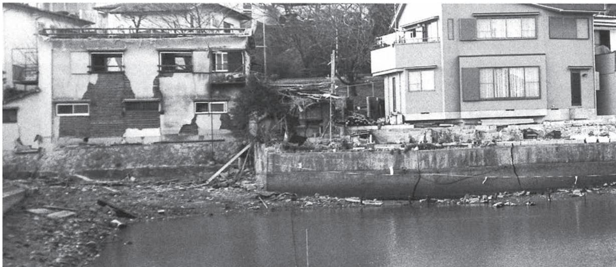
写真3-16 蛍池護岸破損
