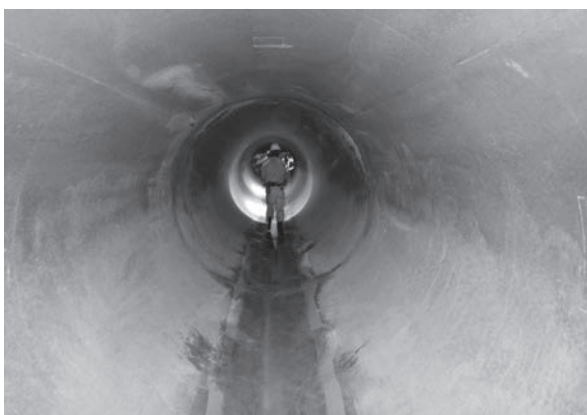
写真4-4 原田中央幹線内部
