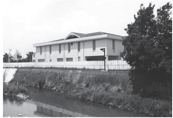
写真4-2 千里園ポンプ場
