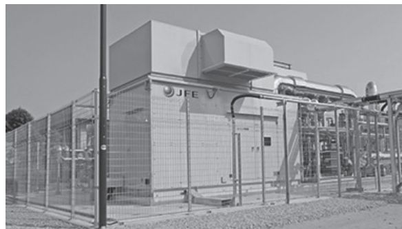
写真4-12 ガスエンジン発電機外観
