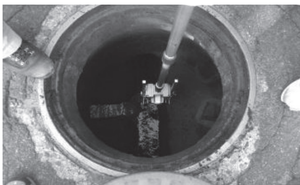
写真4-14 目視による簡易調査
