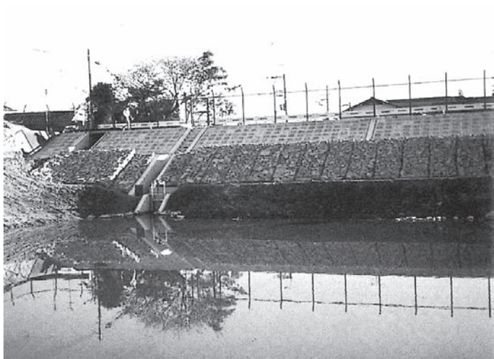
写真3-19 蛭池護岸復旧工事
