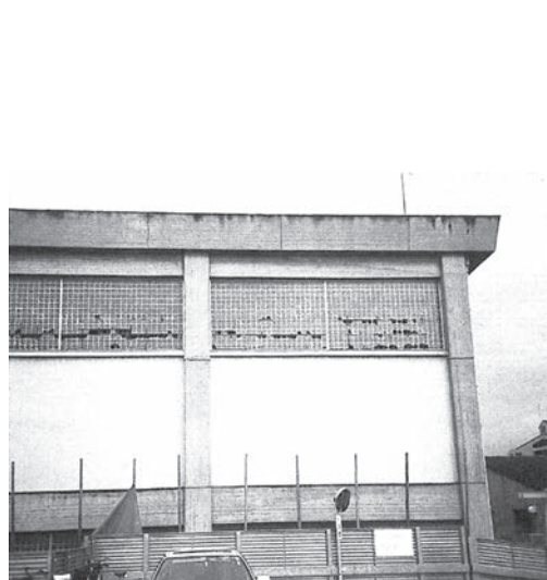
写真3-15 穂積ポンプ場西側ガラス破損
