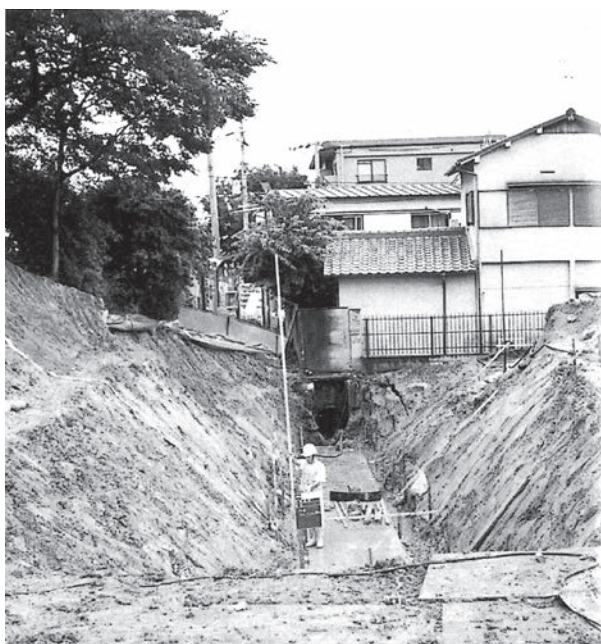
写真3-21 下水設備復旧工事
