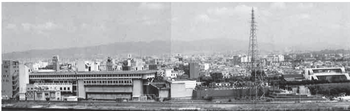
写真2-8 第2期工事完成
