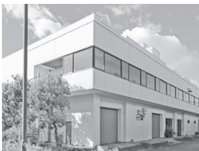
写真2-13 桜井谷ポンプ場外観
