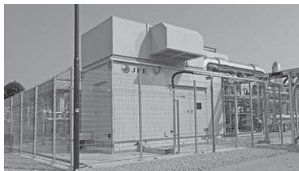
写真4-12 ガスエンジン発電機外観
