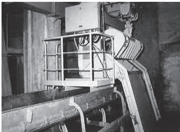
写真2-6 沈砂池（除塵機）
