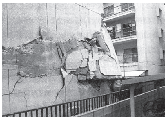
写真4-16 阪神・淡路大震災で1階が壊れたマンション
