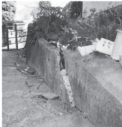
写真3-20 服部耕地整舗装工事(服部寿町3丁目)
