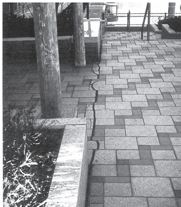
写真3-18 中央幹線景観水路被害
