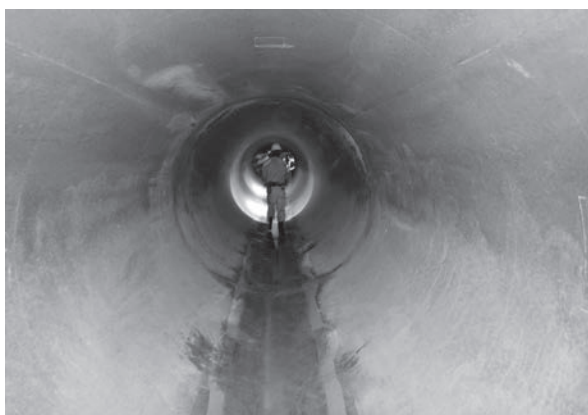
写真4-4 原田中央幹線内部
