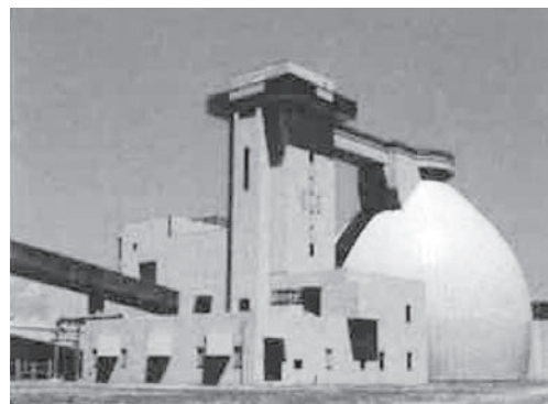
写真3-1 卵形消化タンク
