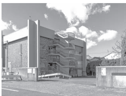
写真2-12 小曾根第2ポンプ場外観
