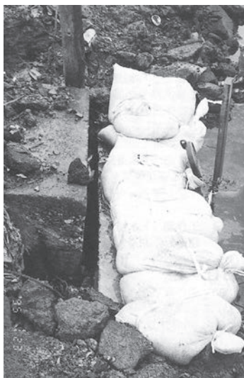
写真3-13 蛍池護岸破損状況
