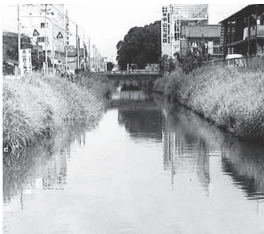
写真2-17 整備前の豊能南部排水路
