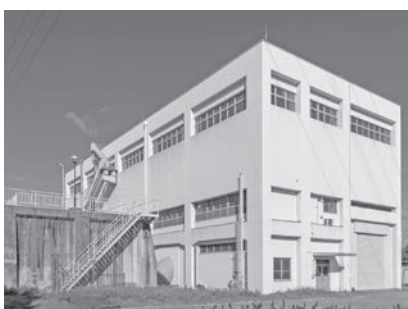
写真2-14 利倉ポンプ場外観
