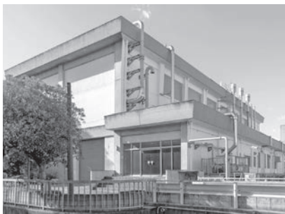
写真2-15 穂積ポンプ場外観
