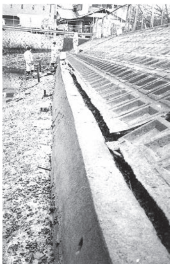
写真3-14 蛍池護岸亀裂
