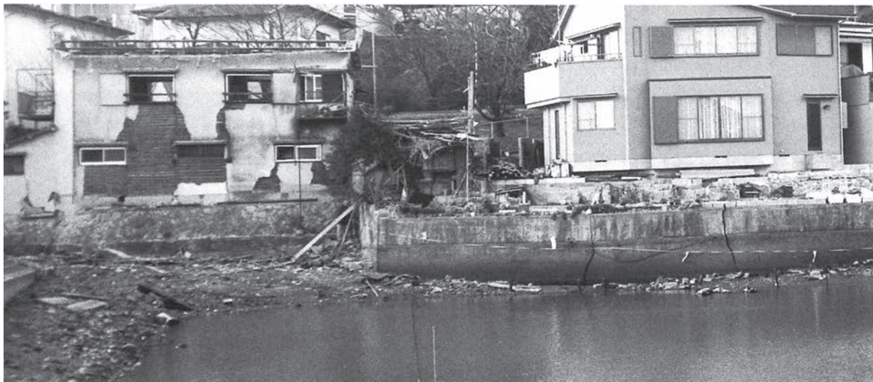
写真3-16 蛍池護岸破損
