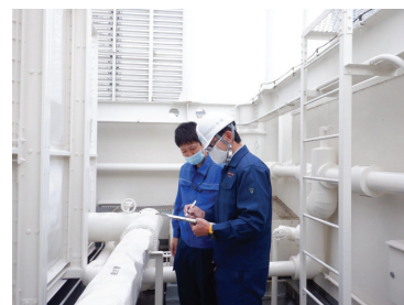
受水槽の管理状況調査の様子
