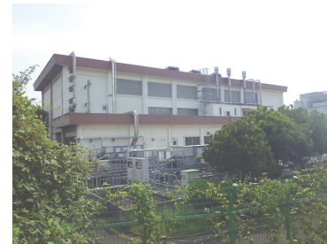
老朽化が進んでいるポンプ場 (穂積ポンプ場)
