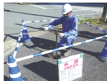
水道施設の点検の様子
