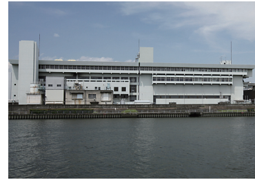
庄内下水処理場
