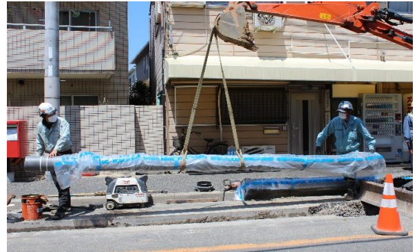
水道管を入れ替えている様子
