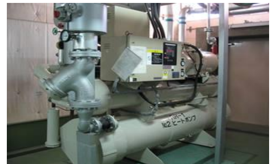
ヒートポンプ方式の冷暖房設備
