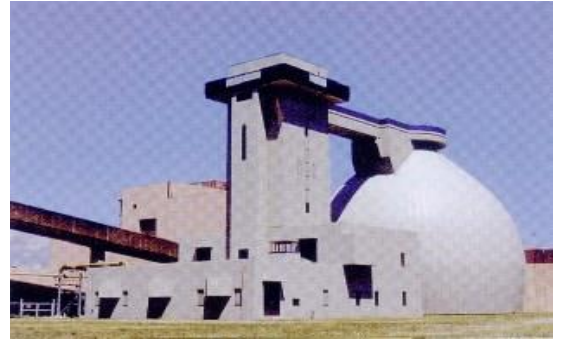
卵形消化タンク（原田処理場）
