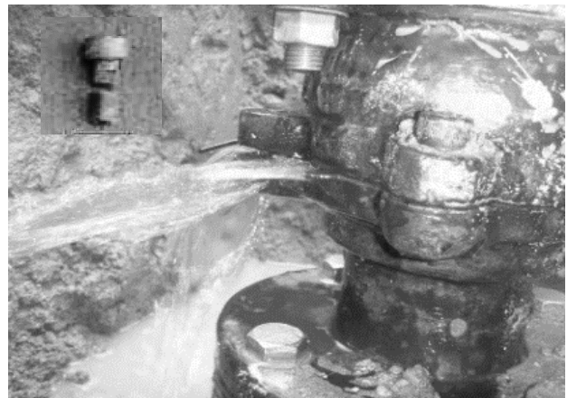
本市における補修弁漏水
