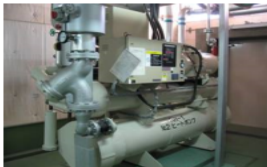
ヒートポンプ方式の冷暖房設備
