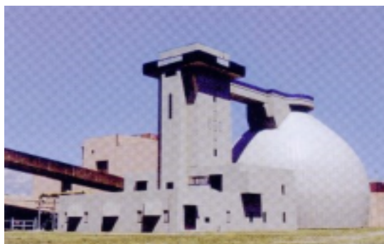
卵形消化タンク(原田処理場)
