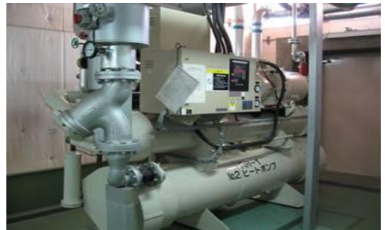
ヒートポンプ方式の冷暖房設備
