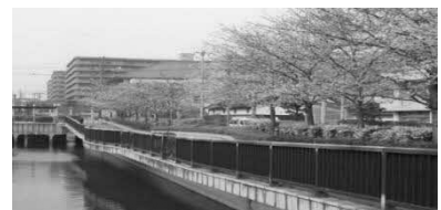
中央景観水路
