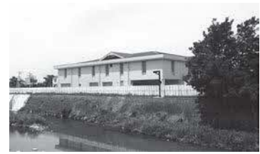
千里園ポンプ場(千里川側)
