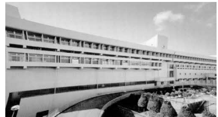
庄内下水処理場
