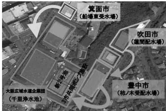
柿ノ木配水場
