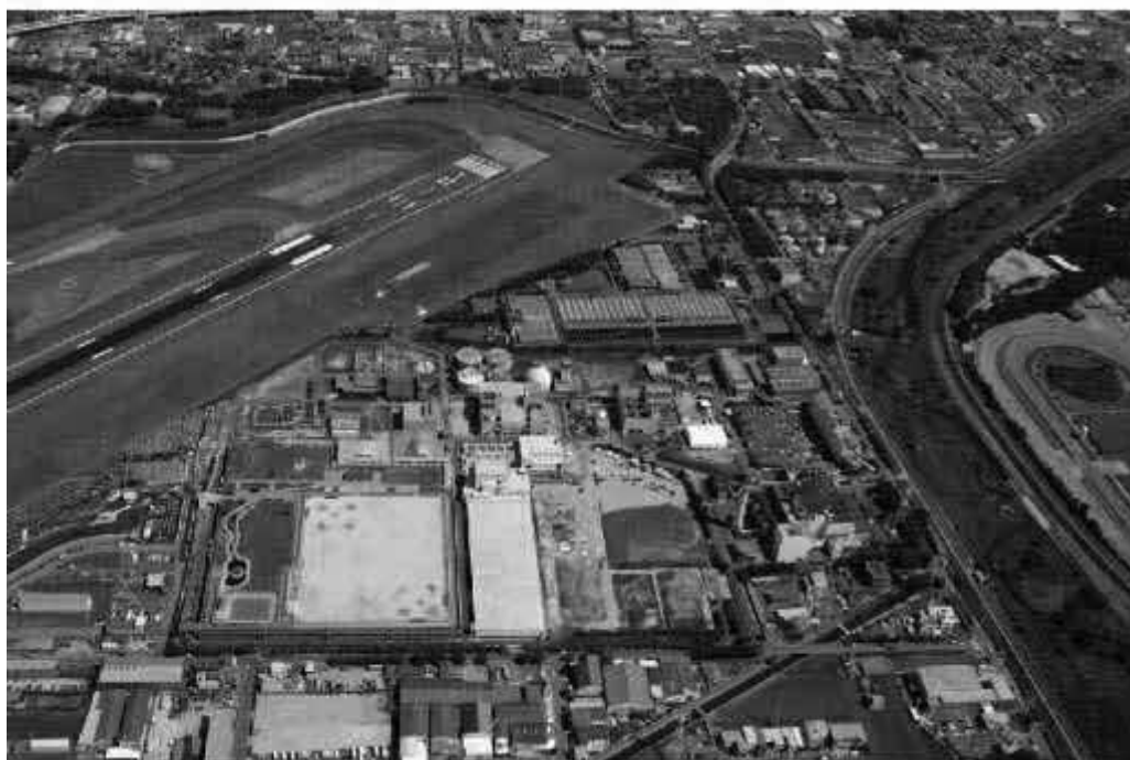
猪名川流域下水道 原田処理場
