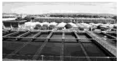
原田処理場 水処理施設
