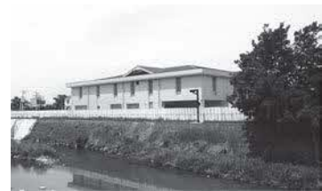
千里園ポンプ場(千里川側)
