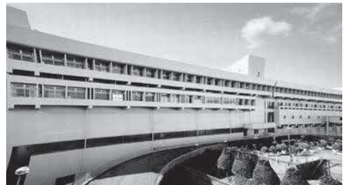
庄内下水処理場
