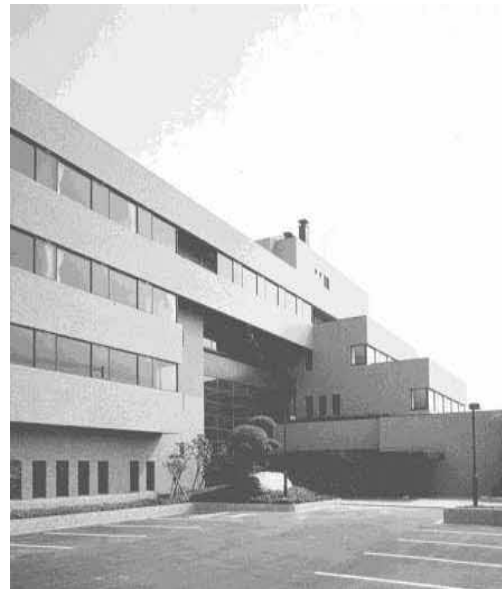
上下水道局庁舎
