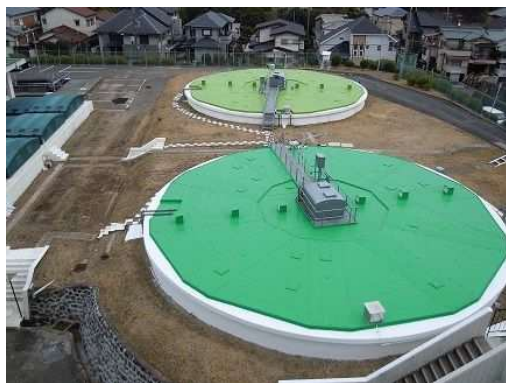
柴原浄水場沈殿池
