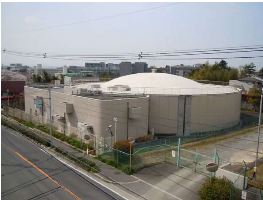
柴原配水場全景
