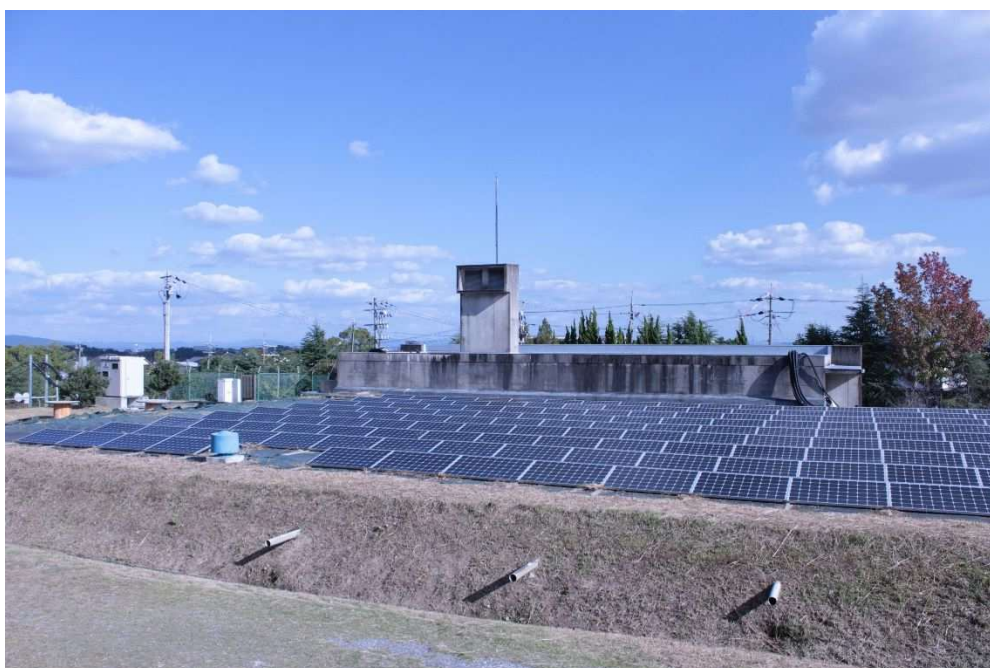
柿ノ木配水場
