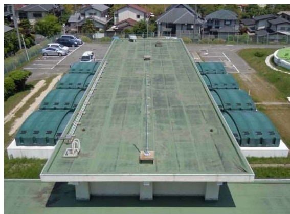
柴原浄水場ろ過池
