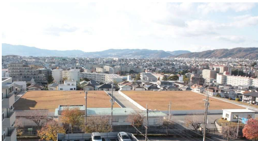
野畑配水場全景
