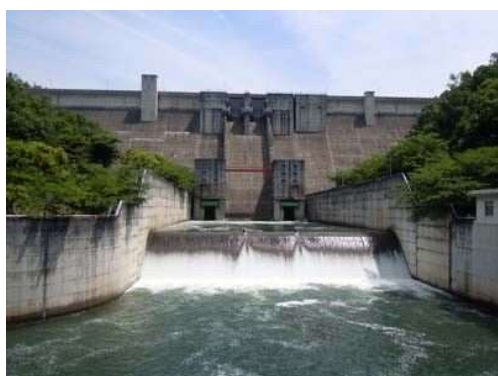
一庫ダム放流設備
