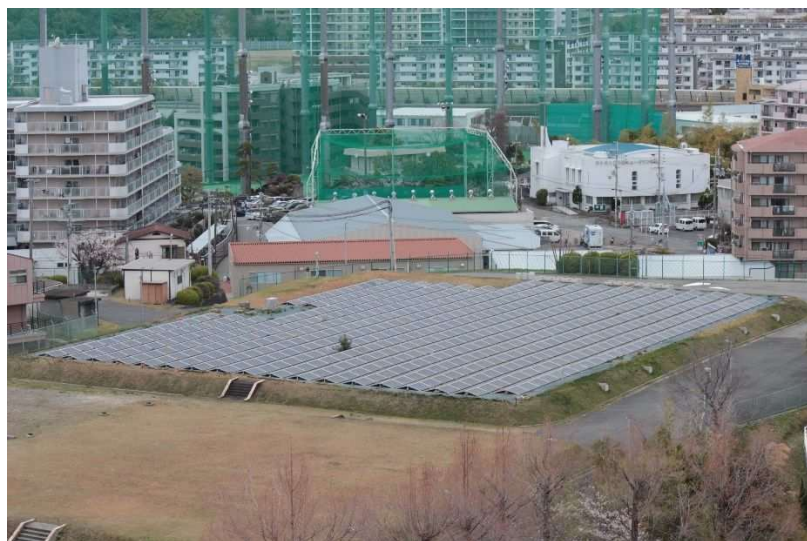
新田配水場全景
