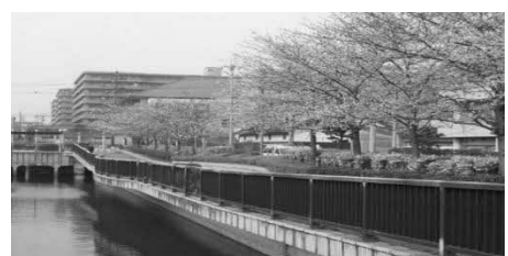
中央景観水路
