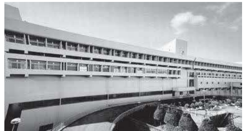
庄内下水処理場
