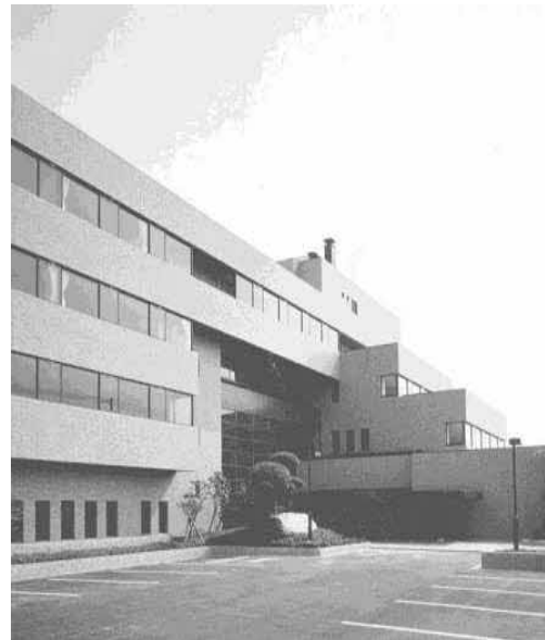
上下水道局庁舎
