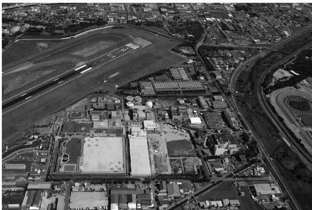
猪名川流域下水道 原田処理場
