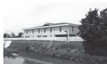
千里園ポンプ場(千里川側)
