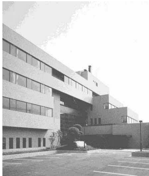
上下水道局庁舎
