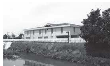
千里園ポンプ場(千里川側)
