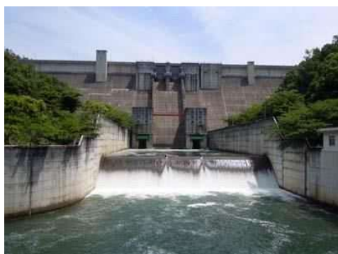
一庫ダム放流設備
