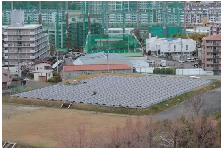
新田配水場全景
