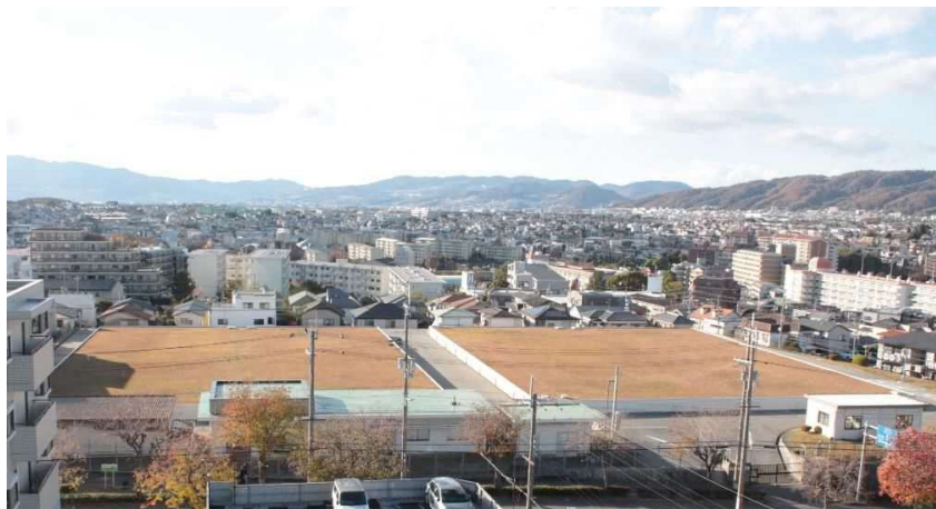
野畑配水場全景
