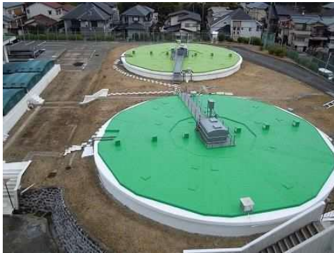
柴原浄水場沈殿池
