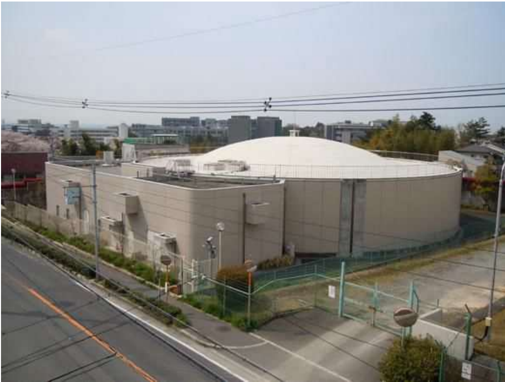
柴原配水場全景
