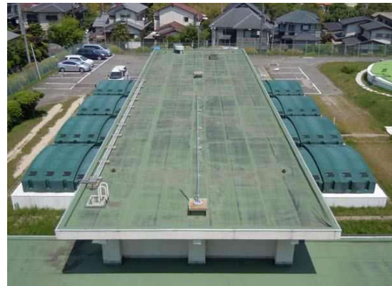
柴原浄水場ろ過池
