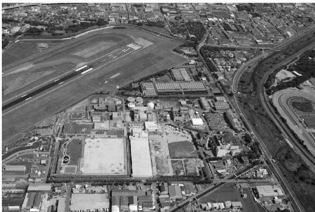
猪名川流域下水道 原田処理場
