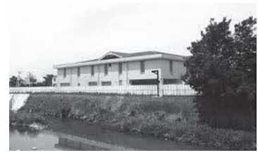
千里園ポンプ場(千里川側)
