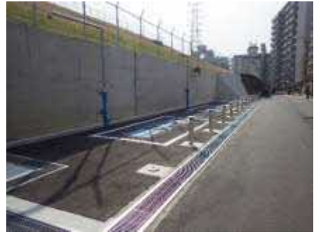
写真：応急給水栓（寺内配水池）
