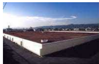
写真：野畑配水池
