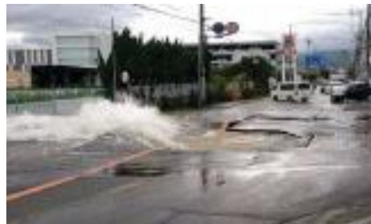
◀水道管破損
