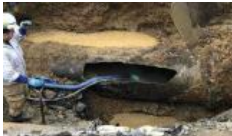
◀水道管破損
