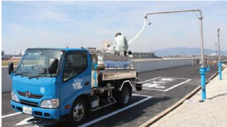
★ 給水タンク車用の給水設備を備えています
