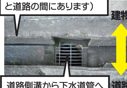
道路側溝から下水道管へここから雨水が流入します。（雨水ますといいます）
