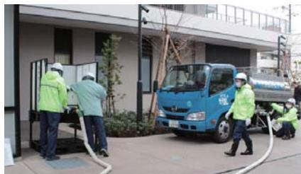
給水タンク車の水を仮設タンクに移し替えて配ります
