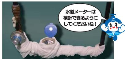
マンションのパイプスペース内での凍結が増えています。左の写真のように保温材やタオルなどを巻き付けて直接寒風に当たらないように保護してください。
