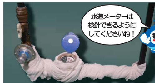
マンションのパイプスペース内での凍結が増えています。左の写真のように保温材やタオルなどを巻き付けて直接寒風に当たらないように保護してください。
