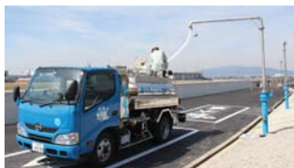
給水タンク車用の給水設備を備えています
