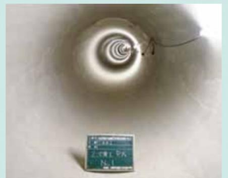
セグメントの内側にコンクリートを打ち込み、雨水が流れるように内径2.4mの下水道管に仕上げます。
