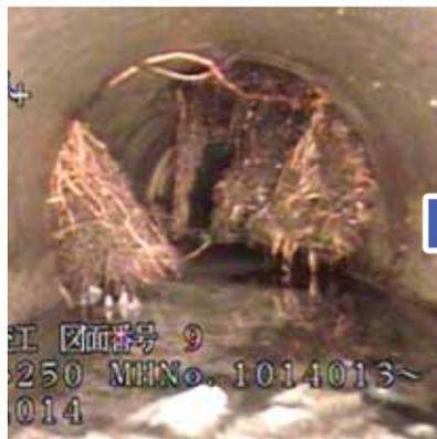
カメラ調査の結果、下水道管全体が老朽化しているだけでなく、継ぎ目から木の根が入り込んでいて、下水が流れにくくなっていることが分かりました。
