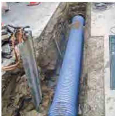
コンクリート管からリブ付塩化ビニル管という外圧(土の重みや車の振動など)に強い管に入替えます。
