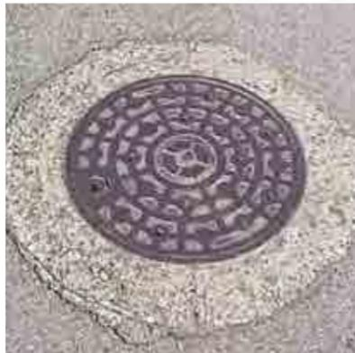
写真は約40年前に設置された古いマンホール蓋です。表面が摩耗して滑りやすくなっていて、危険であると共に、車が通るとガタついてうるさいです。
