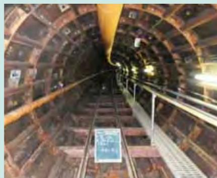
シールドマシンで直径3.3mの穴を掘り進めながら、セグメント(トンネルの外壁)を組み立てていきます。
