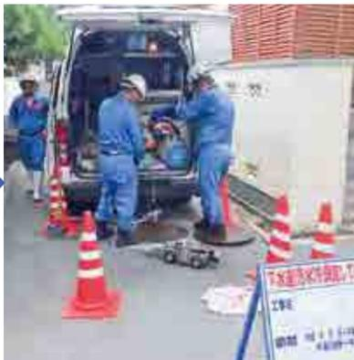
マンホールから自走式のテレビカメラを入れ、洗浄して見えやすくなった下水道管を調査します。
