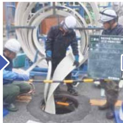
管更生とは、古い下水道管の中に新しい管を造って若返りをはかる工事です。施工方法は多種ありますが、1例として、塩化ビニルやポリエチレンでできた更生材をマンホールから引き込み、らせん状にはめ合わせながら管を造ります。
