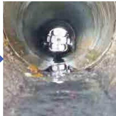
自走式のTVカメラを遠隔操作で動かして、管の破損、ひび割れや浸入水を見つけ、写真を撮影します。
