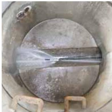
下水道管の中を見えやすくするために、洗浄ノズルから高圧で水を噴射し、管内を洗浄します。管内にたまった土砂などを洗い流します。
