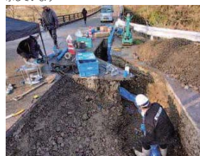
新しい水道管が敷設されています
