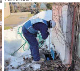
漏水が起きていないか、水が流れる音で聞き分けます
