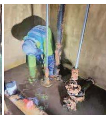
配水池内のバルブを操作可能にするため、固着した鎖を取り除きます
