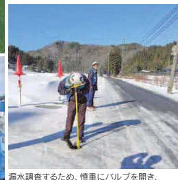
漏水調査するため、慎重にバルブを開き、水道水を流します
