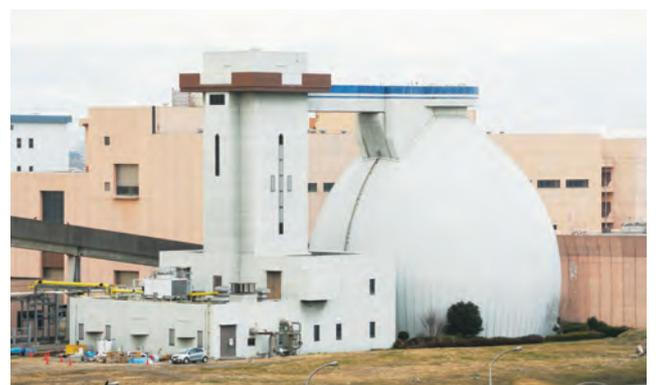
消化ガスを発生させる卵形消化タンク(原田処理場)
