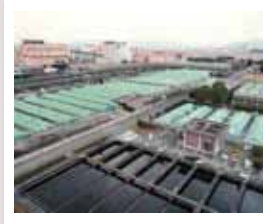
猪名川流域下水道原田処理場
