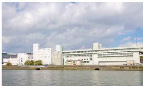
庄内下水処理場は、豊中市南部地域の水洗化と、水質保全や浸水対策などを目的に、昭和48年(1973年)に誕生した施設です。平成17年(2005年)には、施設の3分の1に高度処理方式を導入し、これまでよりもきれいな水に処理できる施設になりました。1日に約5万8千m<sup>3</sup>の下水をきれいにし、神崎川へ戻しています。
