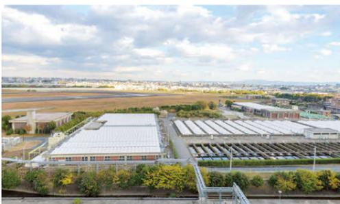
猪名川流域下水道原田処理場は、昭和41年(1966年)に稼働開始。大阪府・兵庫県の6市2町(豊中市・池田市・箕面市・豊能町、伊丹市・川西市・宝塚市・猪名川町)の下水を処理しています。1日に約77万人分の下水と工場排水、合わせて約30万m<sup>3</sup>の下水をきれいにし、猪名川へ戻しています。施設の5分の3で高度処理方式を導入しています。
