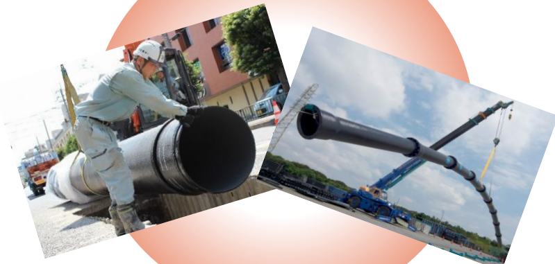
材料費等の高騰による工事費用の増加
