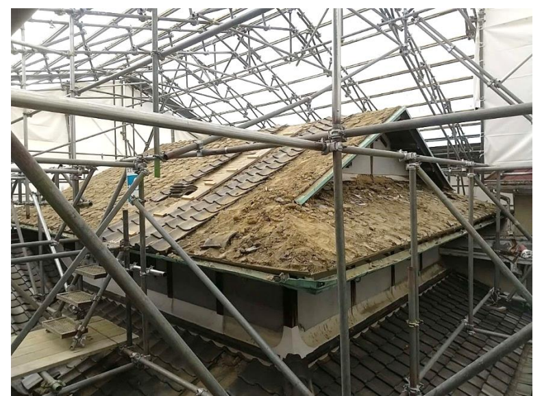
▲西山家住宅 離れの屋根修復
