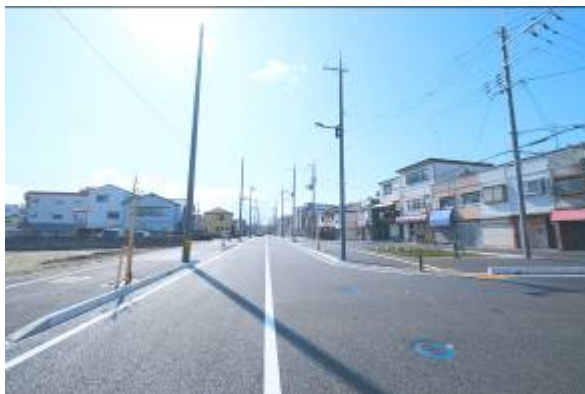
令和元年度完成区間
