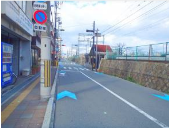
令和元年度（2019年度）整備箇所
