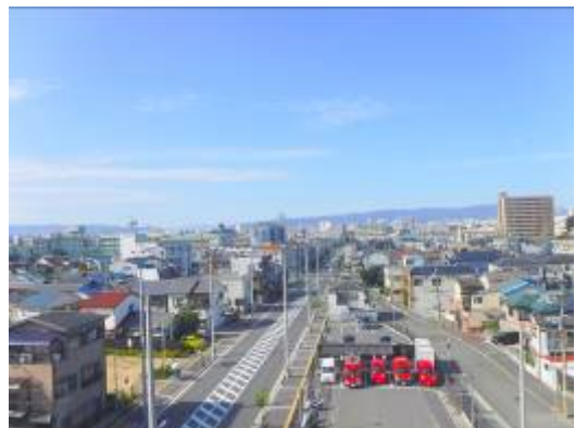
完成区間/三国塚口線以北
