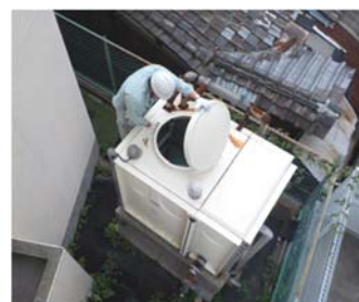
受水槽の管理状況調査のようす
