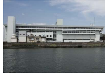
庄内下水処理場
