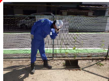
漏水防止活動のようす
