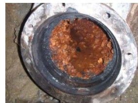
古くなった水道管の内部
