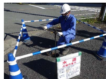
水道施設の点検のようす
