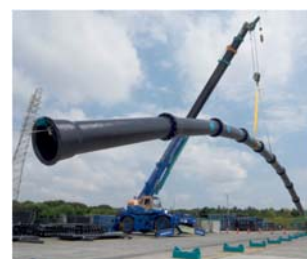
耐震管※のデモンストレーション
