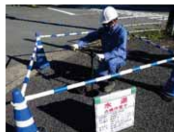
水道施設の点検のようす
