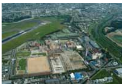
原田処理場の全景
