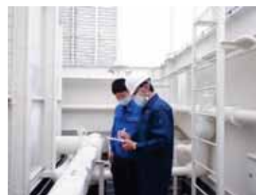
受水槽の管理状況調査のようす
