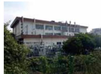
老朽化が進行しているポンプ場 (穂積ポンプ場)
