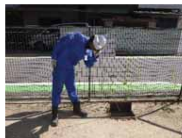
漏水防止活動のようす
