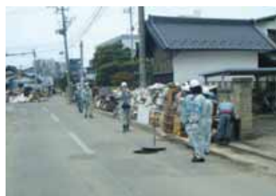
東日本大震災の被災地での下水道管調査のようす(宮城県多賀城市)
