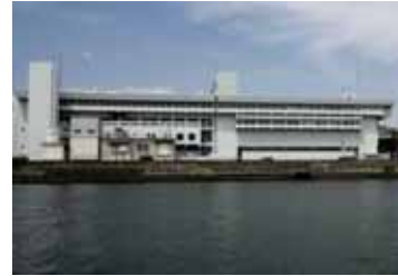
庄内下水処理場
